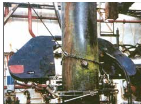
▼ Trabajos de desmantelamiento con sierra de cinta.
