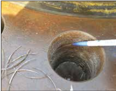
▲ Una rosca típica antes de la reparación
