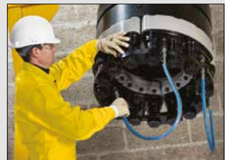
▲ Aplicación de tensionado multiespárrago.
