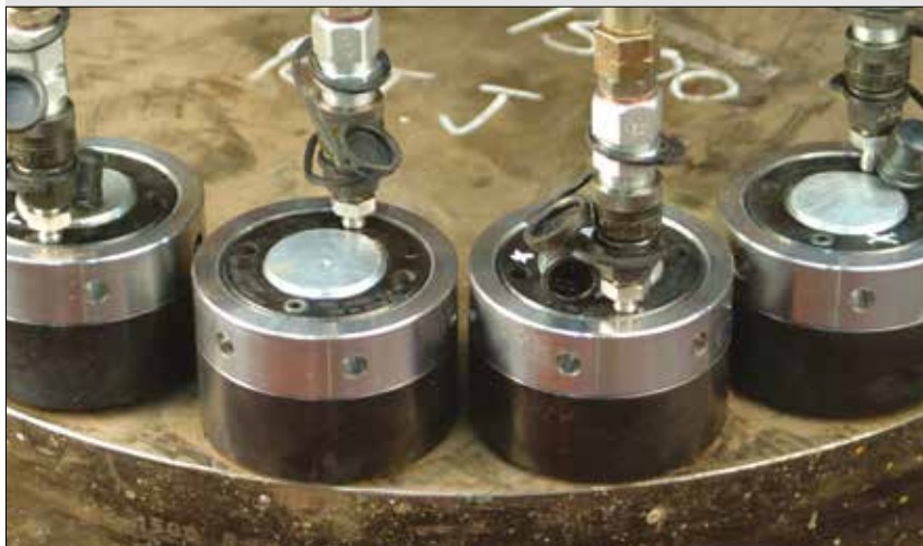
▲ Tensionado con tuercas hidráulicas.
