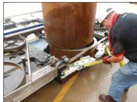
▲ Corte de tubos con sierra de cinta portátil BS.
