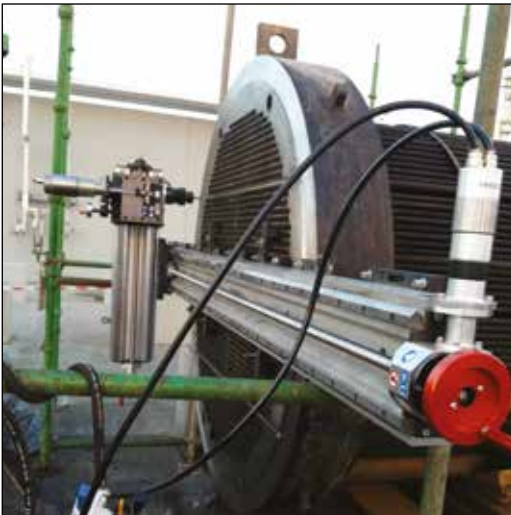
▼ Fresadora MRY en un intercambiador de calor.
