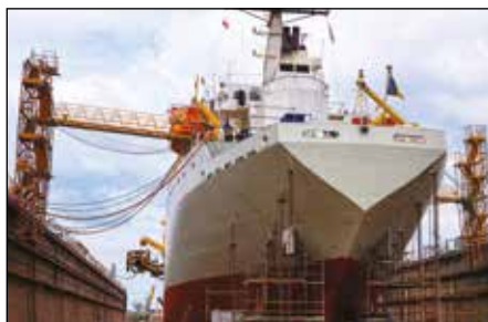
Construcción, Mantenimiento y Reparación de buques
